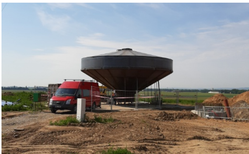
výstavba vodojemu na Panském kopci v Šumvaldě
